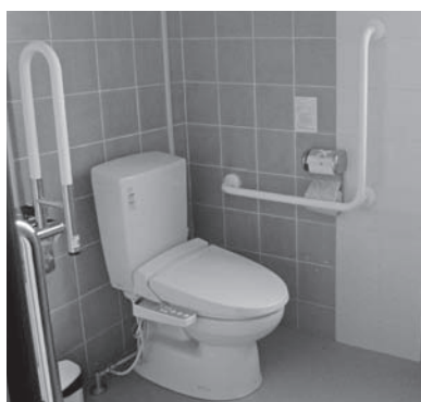
改修された中央会館のトイレ
