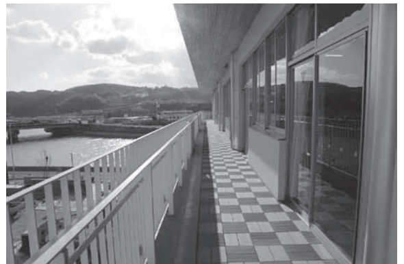
普通教室の窓際にあるバルコニー
